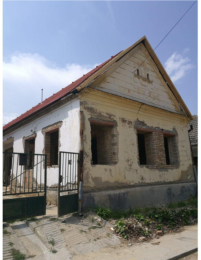
A Fő utcai ház átépítése
